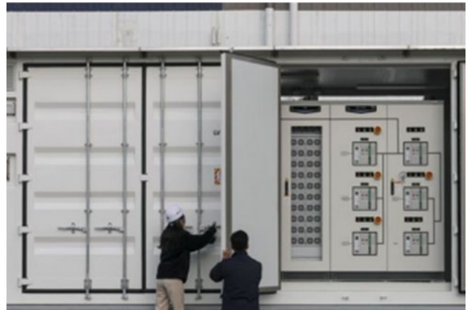
그림 215. LS일렉트릭 DC 팩토리 내 SST
