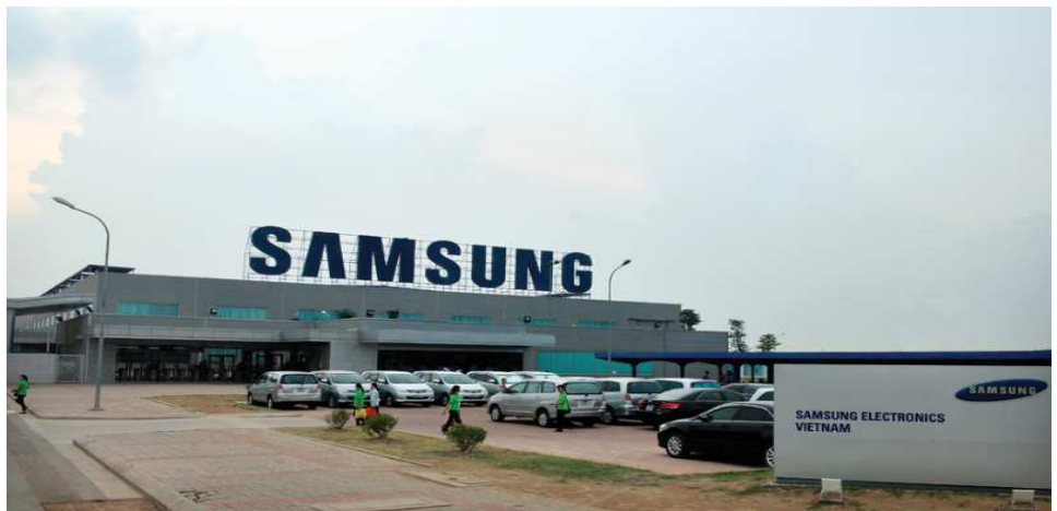
그림 9. 베트남 삼성전자 공장
