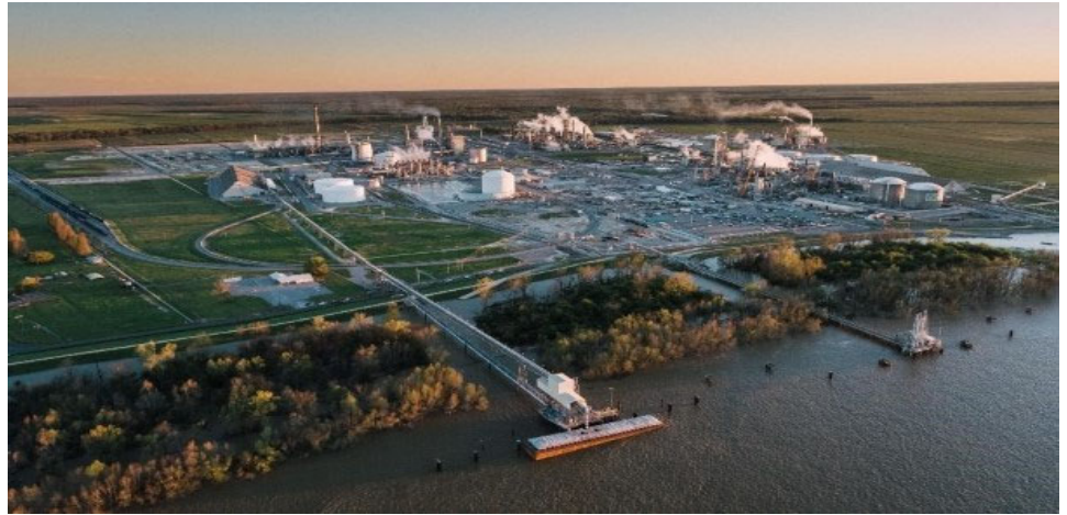
그림 18. Donaldsonville 질소 복합단지
