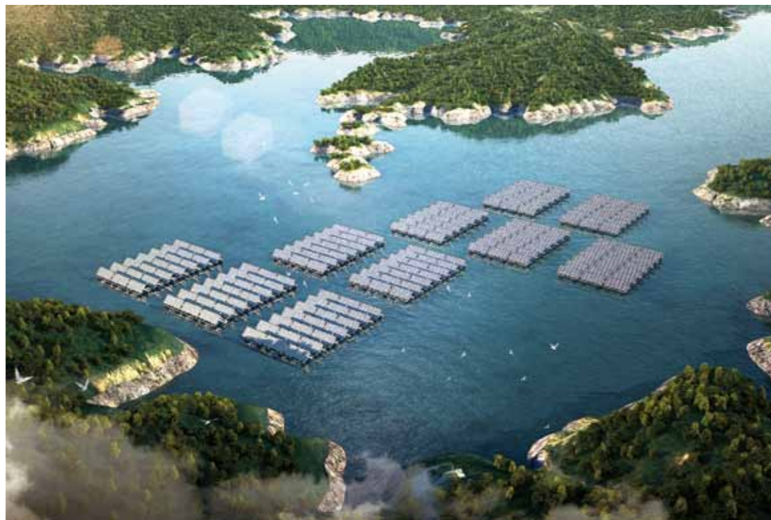
합천댐 수상태양광 부분조감도
